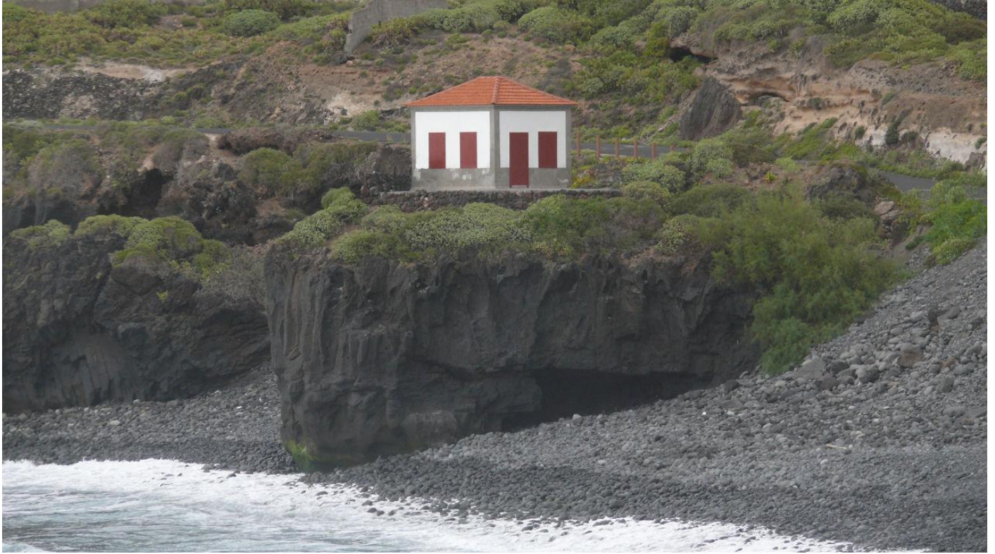
Imagen 01. Caseta de amarre del cable submarino telegráfico trasatlántico de 1883 en la costa de Los Silos (Playa de Agua Dulce - Piedra Redonda). Fotógrafo. Pedro Augusto Báez Díaz.
